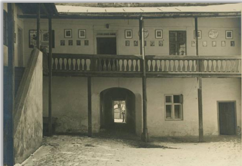
Obecná a měšťanská škola Brušperk. Chodba v části vymezené pro obecnou školu. Žáci měšťanské školy zde v zimních měsících cvičili.
